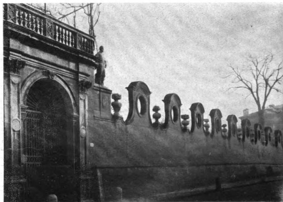
Muro di cinta del giardino del Palazzo Varano.
